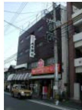
「自立支援住宅」外観
