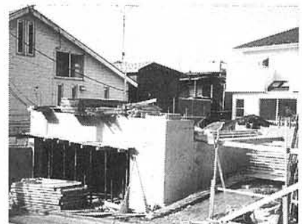
計画確認チームによる建築現場写真
