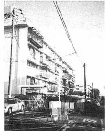
千本地区公営住宅
