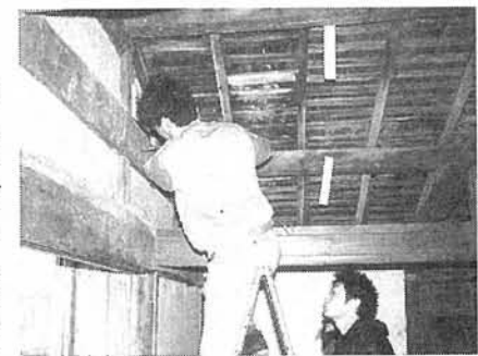
構造部材強度調査
