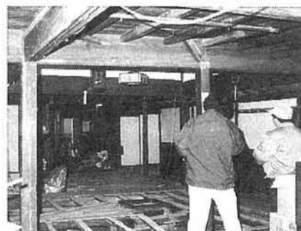
野尻邸内装材の撤去
