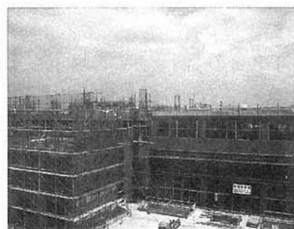
開始された建替工事
