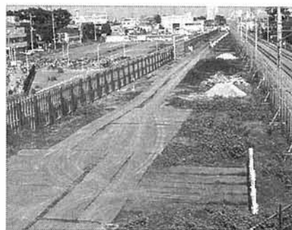
仮線工事が始まった東小金井駅周辺
