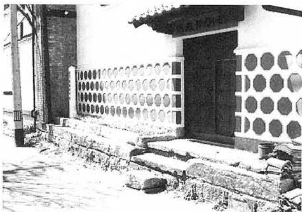
再生された蔵（入口、踏台が再利用）
