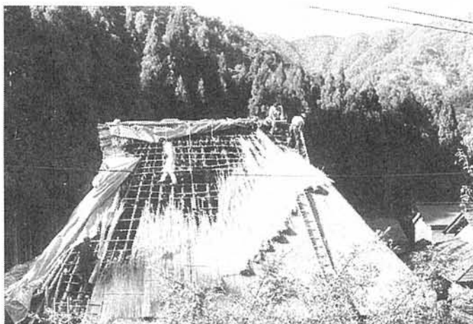
葺き替え作業中
