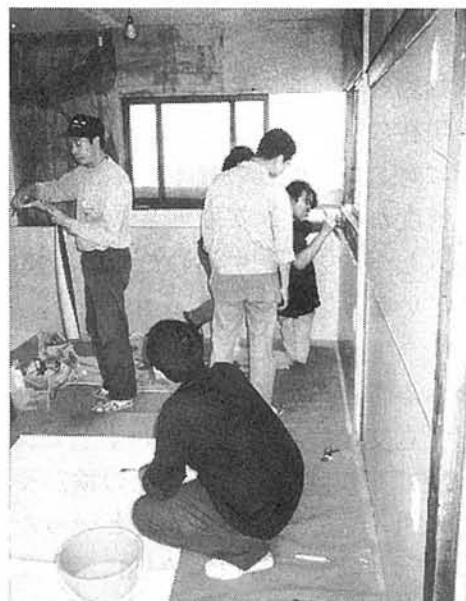
改修工事（居室）
