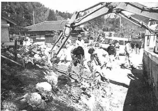
案内板設置作業
