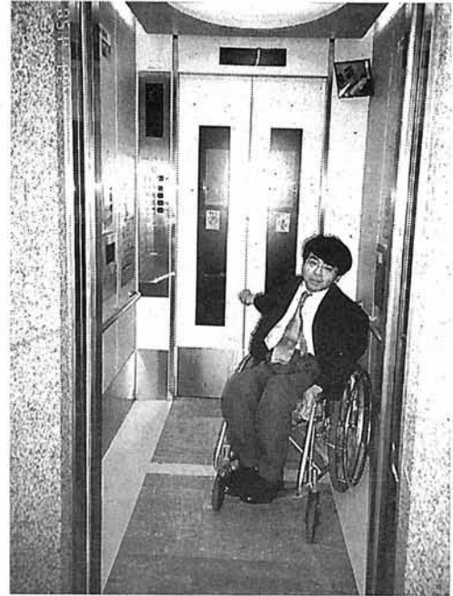
多摩センターのエレベーター 双方向の利用可
