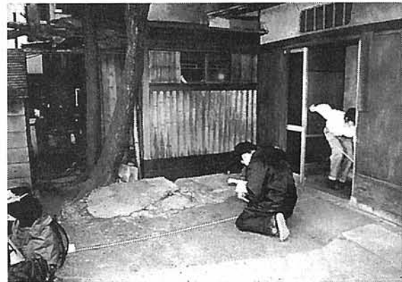
協働会館第6寮 建物調査
