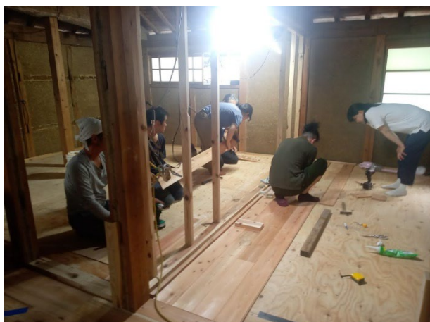
板を貼る作業
