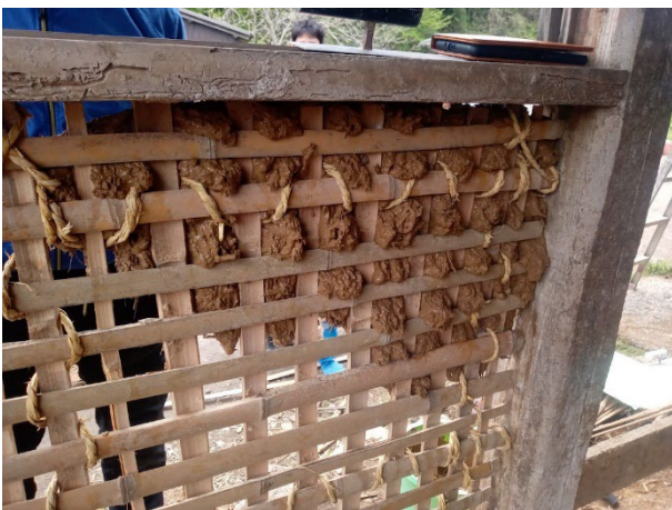
土は小舞に押し付けるように塗る
