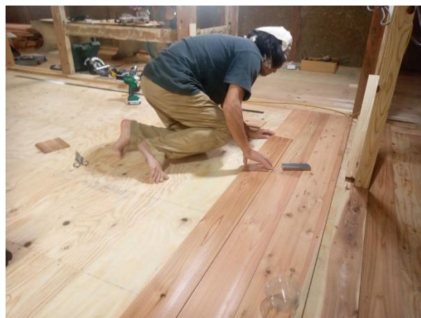
長さの違う板を組み合わせながら貼る
