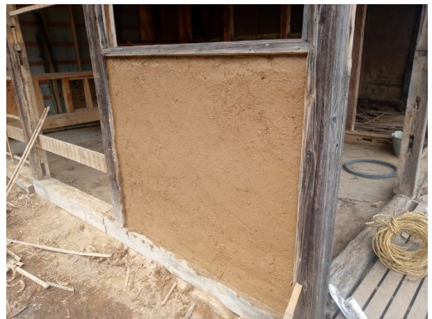
出来上がった土壁
