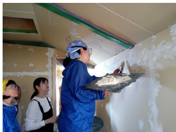
テープを貼って養生する
