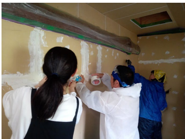
ネジ穴やボードの境目の穴埋め作業
