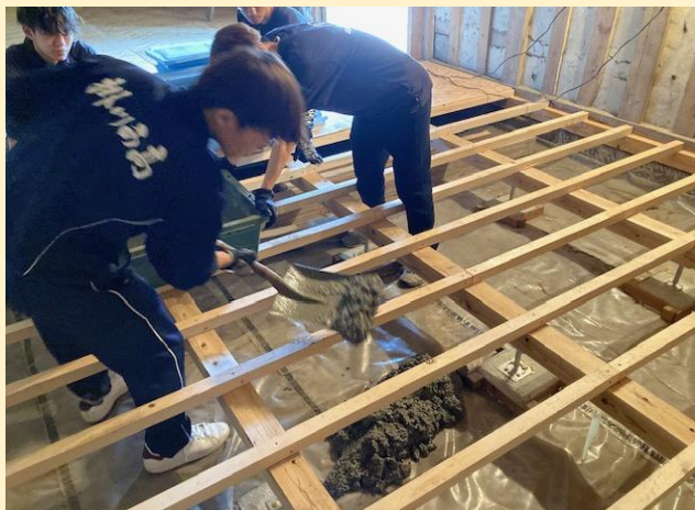
補強コンクリートの打設
