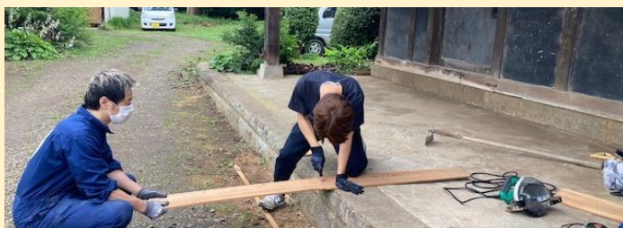
コンクリートに荷重を伝える支持材を加工
