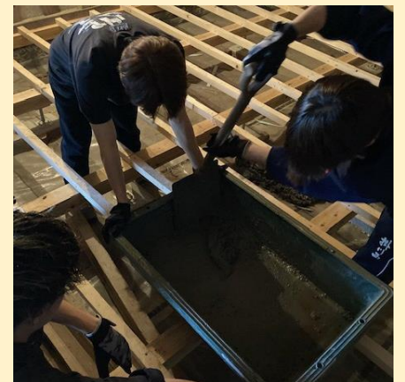
補強コンクリートの打設
