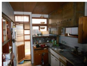
改修前の様子
