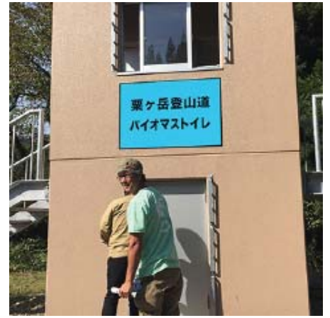
バイオトイレの匂いや設置条件を視察確認。 ➡旧動物小屋を改修する計画を変更し、畑のエリアの小屋を新設することにしました。また、太陽光発電を導入し、匂いを飛ばすシステムを入れることにしました
