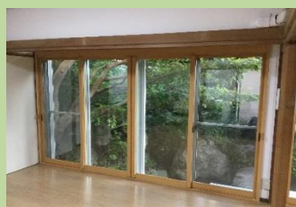
既存のサッシに高性能断熱ガラスのサッシを追加
