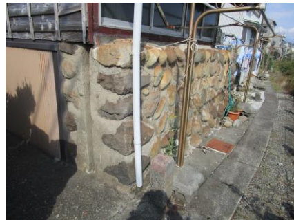
かつて海に面していた防波石垣、堰板を嵌める溝↑も残されている
