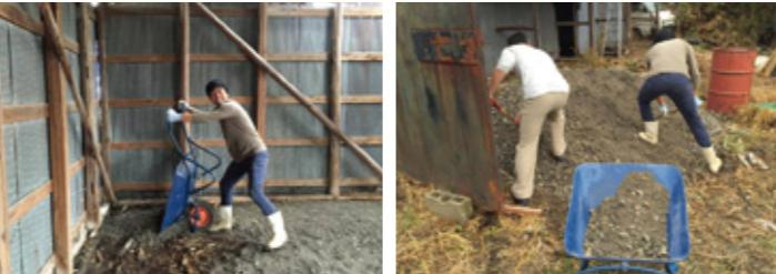
腐朽部分の除去を行い、切断した柱の下にコンクリートブロックを挿入し、補強を行いました。切れないので鋸を素人が使う為に作業に苦戦し、「道具」の重要性を改めて認識しました。
