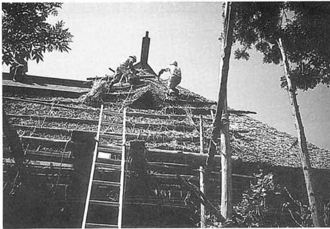
茅葺屋根の補修作業
