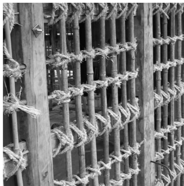
今回の能登半島地震は、能登地域の土蔵を作ってきた工法の弱点を露呈させた。再び地震が起きても壊れない土蔵へ。そのために幾多の技術的な改良を加えた。竹小舞だけでも地震に耐えられるようなものを目指した。
