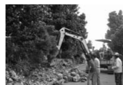
崩れた石積みを取り除く
