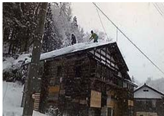
屋根の雪掘り
