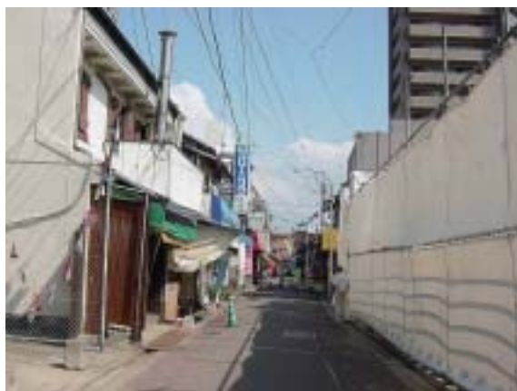
マンションの建設が続く商店街
