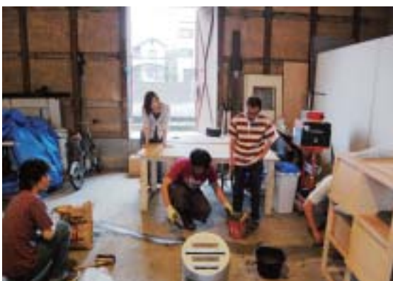
蛸蔵の改修作業 1
