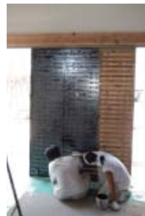
蛸蔵の改修作業 2
