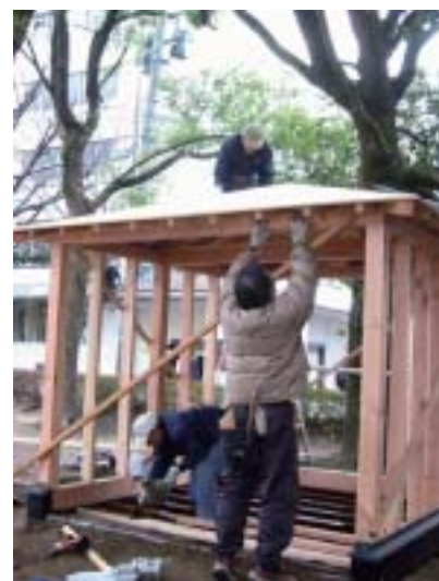
カフェハウスの建設 2
