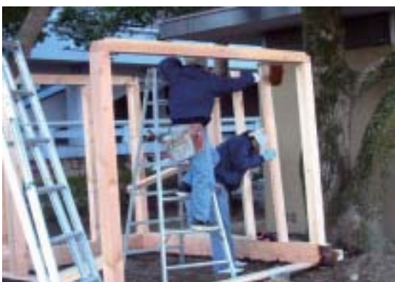
カフェハウスの建設 1
