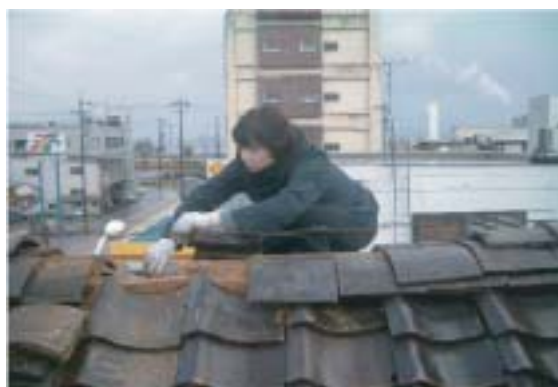
建物応急補強工事 1
