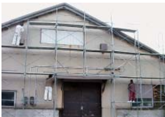
建物前面調査
