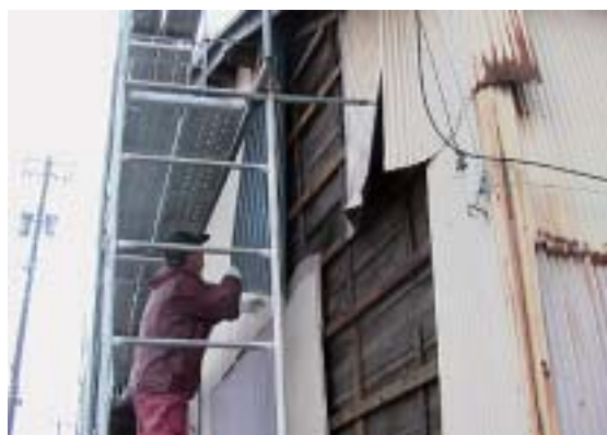
トタンで覆われている壁面をはがしながら調査
