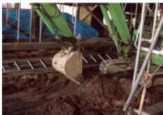
花道、奈落遺構調査 2
