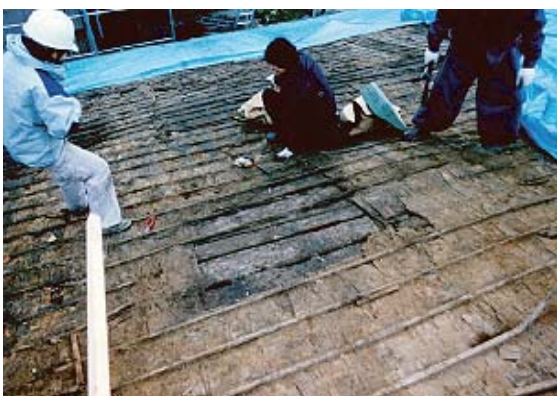
建物応急補強工事 2
