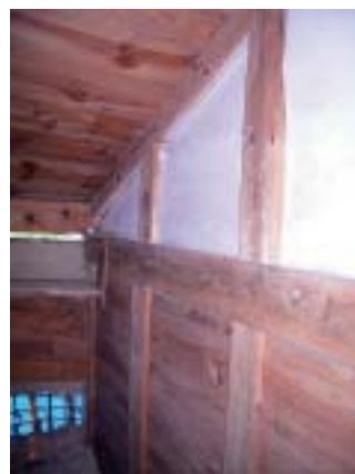
土蔵内部(落とし込み板)
