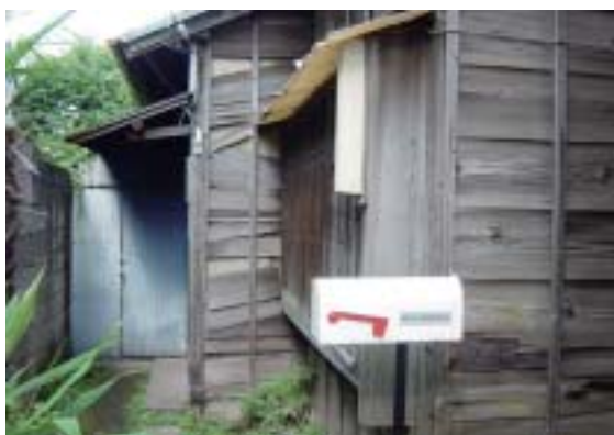
活動拠点としている古民家の入口
