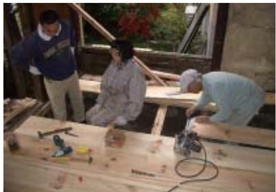
蔵再生ワークショップ 2 床板の張替え
