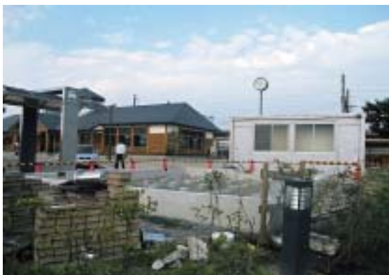
「なんでも屋」の基礎工事
