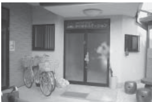
事務所1階の地域交流スペースの入口
