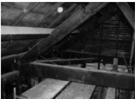
西側三角屋根 小屋組み
