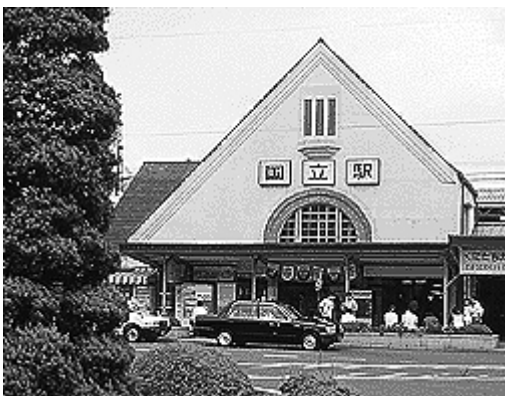
大きな半円形の窓と三角屋根が特徴的な国立駅舎
