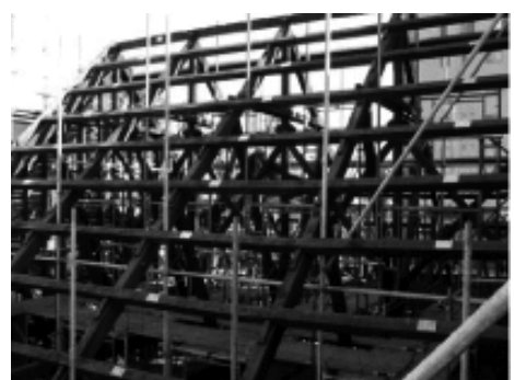
正面三角屋根 小屋組み(西側)
