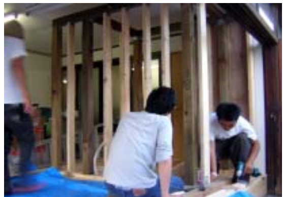
学生によるトイレ新設の様子
