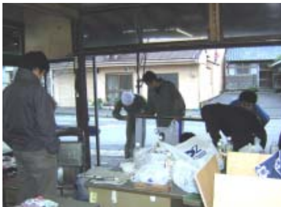
学生によるサッシ修理の様子
