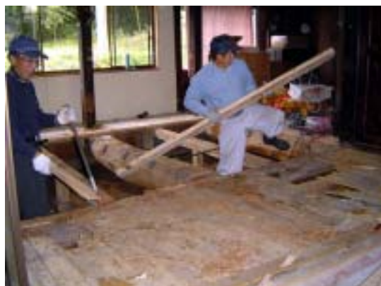
古民家の床の修理の様子 1
