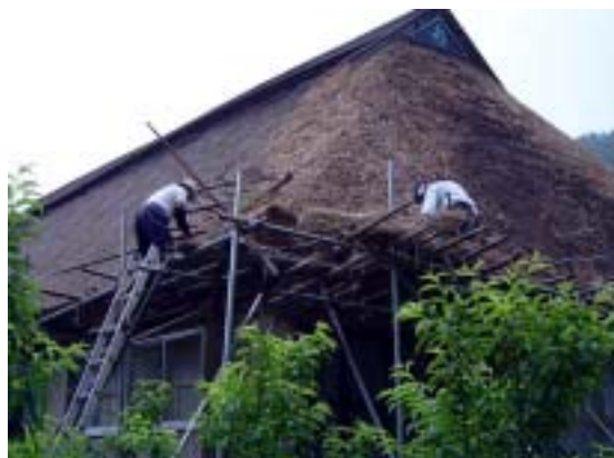
たいいち宅の屋根の修理作業
