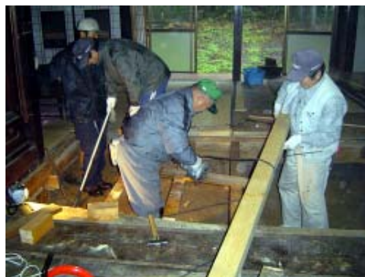
古民家の床の修理の様子 2
