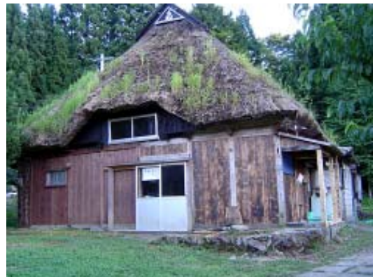
みのる宅の外壁交換作業完成風景
