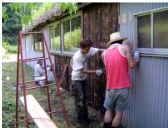
みのる宅の外壁交換作業
