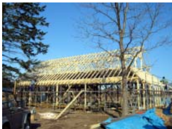
古民家の屋根工事
