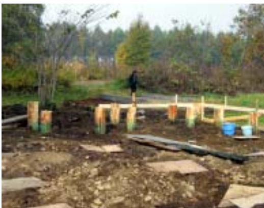
建物本体の基礎の丸太打ち
