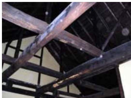
古民家の内部の梁
