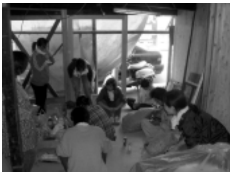
長屋の改装工事(セルフビルド)の様子
