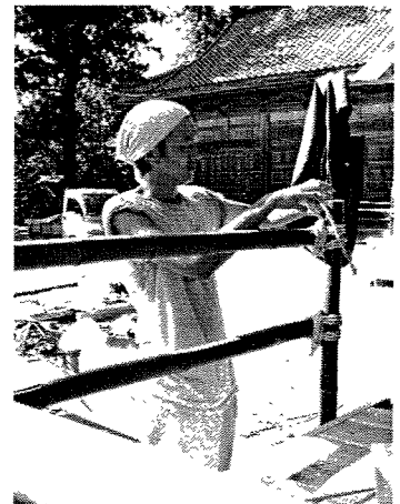
竹の欄干を作成している様子
