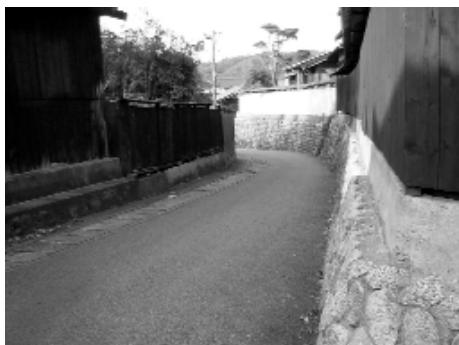
黒塀化が進められている町並み
