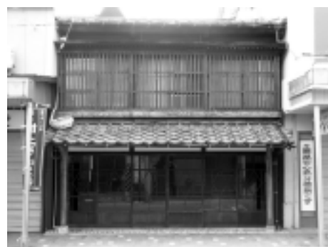
再生の様子 2 瓦、格子、木製硝子戸が取り付けられた
