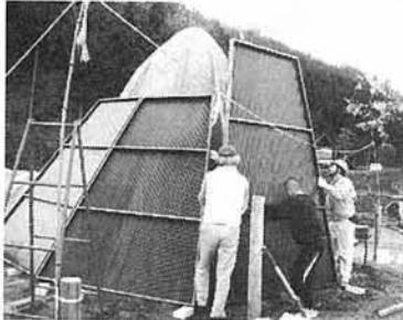
この粘土の家の焼成のために設計し、現地で作りあげたトタン窯を組み立てる
