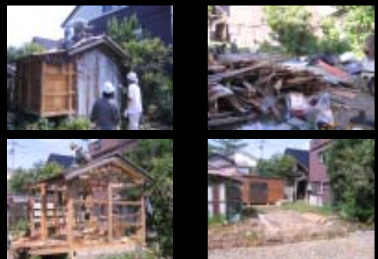
アプローチ上の倉庫を新築移転し、旧倉庫を解体、廃材を処分場へ運搬
