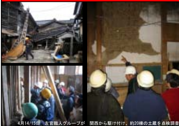
4月14/15日 左官職人グループが 関西から駆け付け、約20棟の土蔵を点検調査
