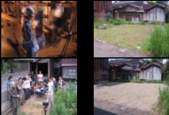
土蔵の剥離した壁土を叩き落とし処分場へ 隣接空き地の草むしりの後砂利敷き
