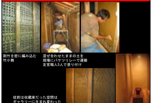
壁厚を薄くする工法での修復
