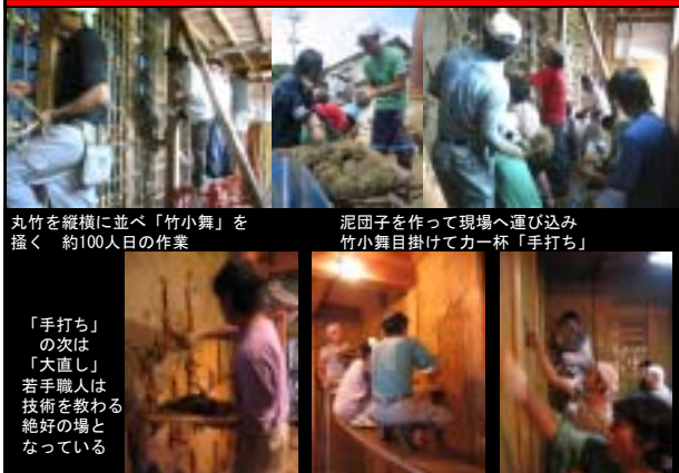
伝統的な土壁に近い工法での修復
